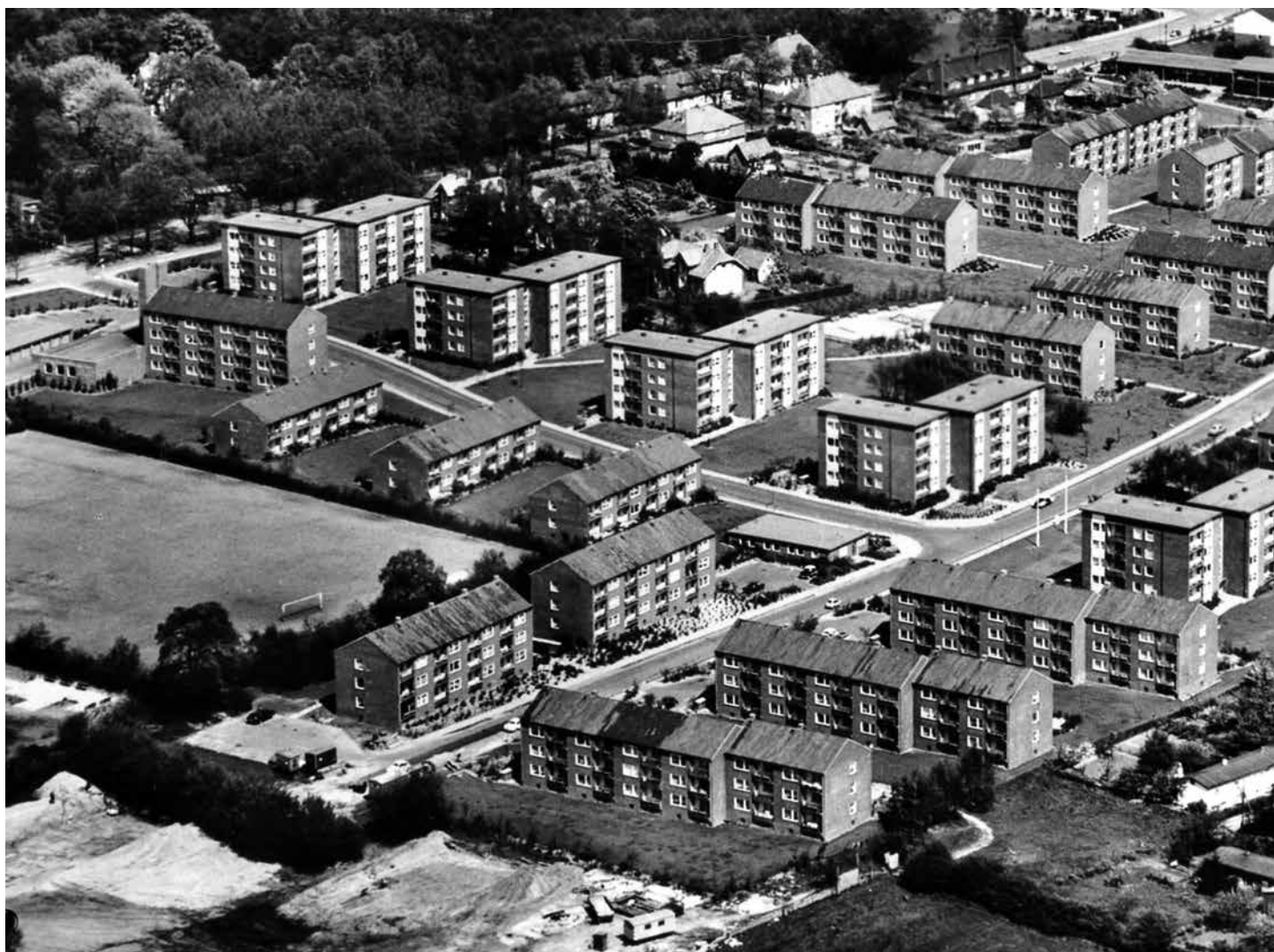
Eine der wenigen Luftbildaufnahmen der damaligen Zeit – noch ohne Baum und Strauch.
